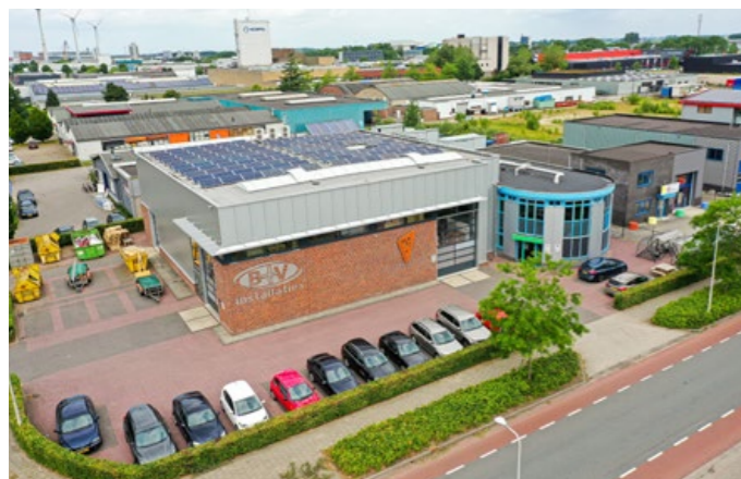
Renovatie | Boer en Van Veen Ambachtsstraat 25a, Kampen
